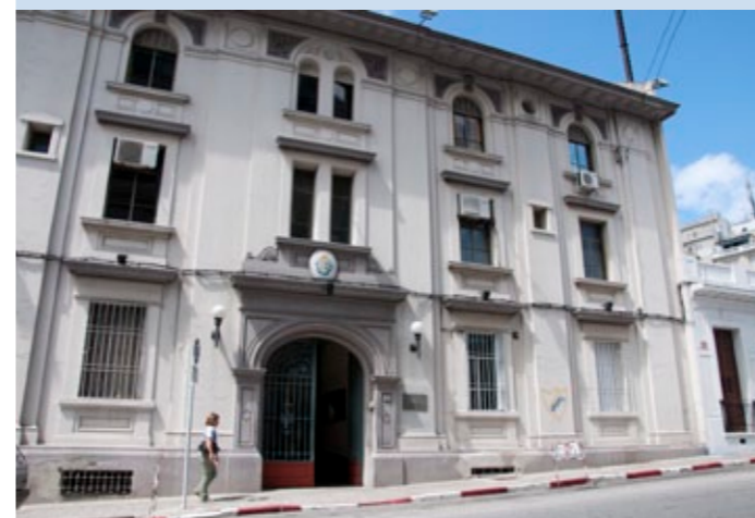
Edificio de la Dirección Nacional de Meteorología.
