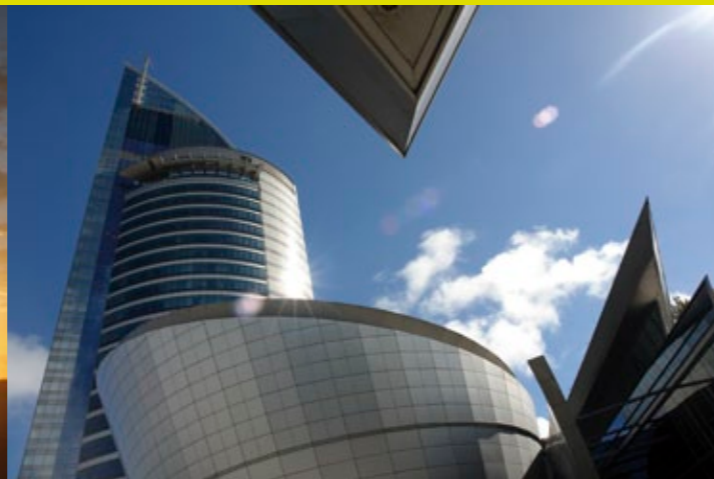
Torre de las Telecomunicaciones de Antel.
