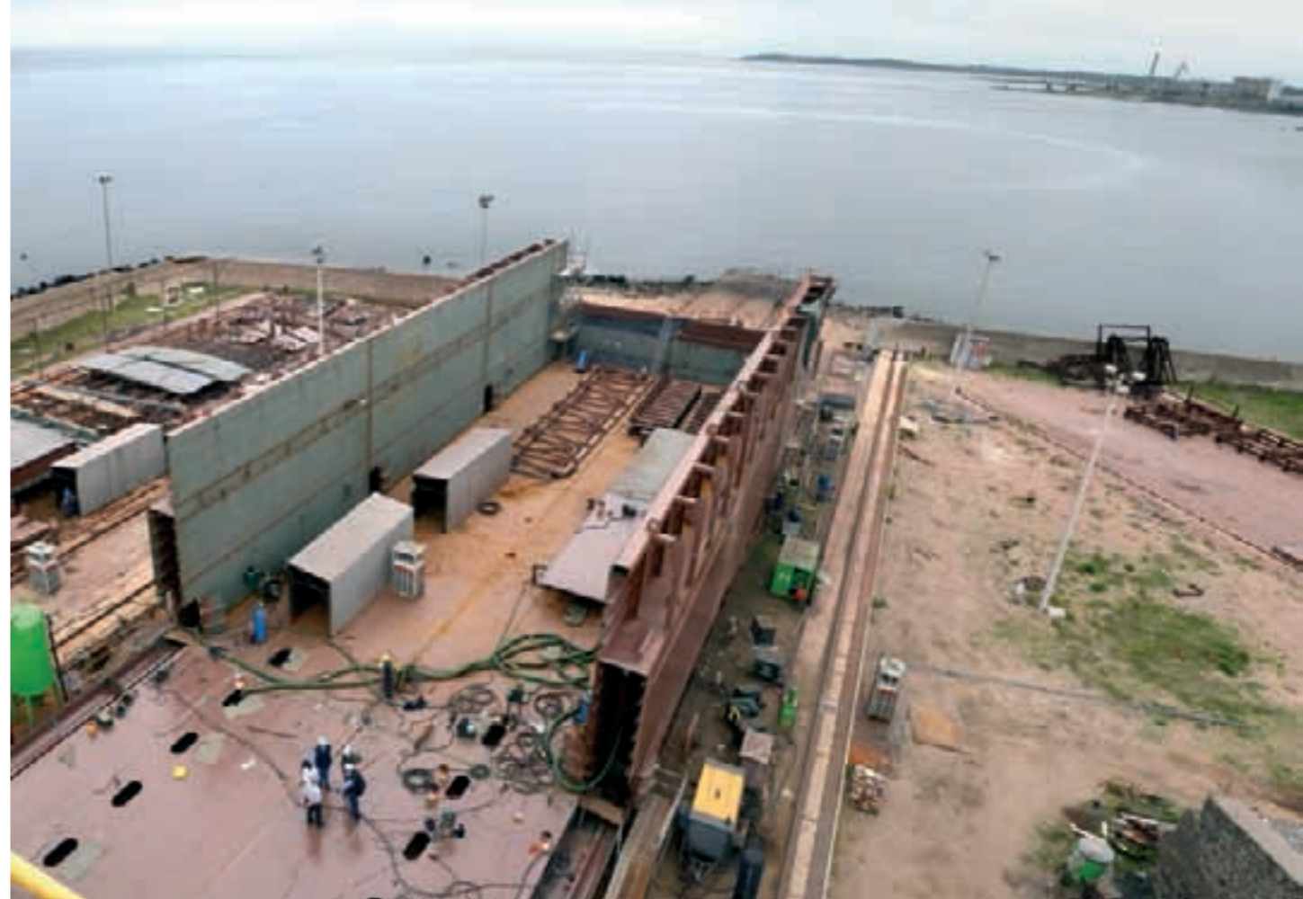
Construcción de la tercera barcaza para Montes del Plata a cargo de Galictio Tiferey en el Astillero de la Armada.
